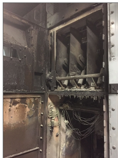
(d) Switchgear failure and fire
